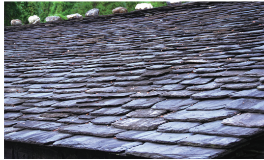
石板屋頂的蛇鱗排列方式（圖片來源：camak 拍攝）
