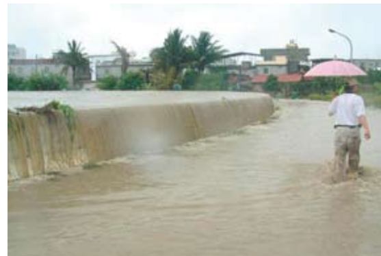
● 典寶溪排水溢堤
