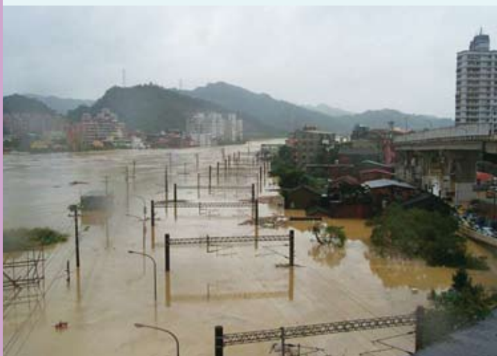
● 象神風災的五堵車站淹水慘況
