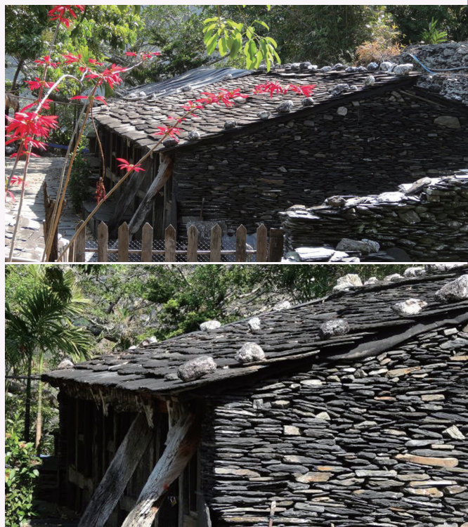
春日鄉老七佳部落石板屋建材取自板岩，牆面堆疊石板；但屋頂和迎風牆面為求防風、防水，由下而上依序鋪排，類似魚鱗、覆瓦狀，是傳統排灣、魯凱族人的建屋方法。（圖片來源：鄭碧雪拍攝）
