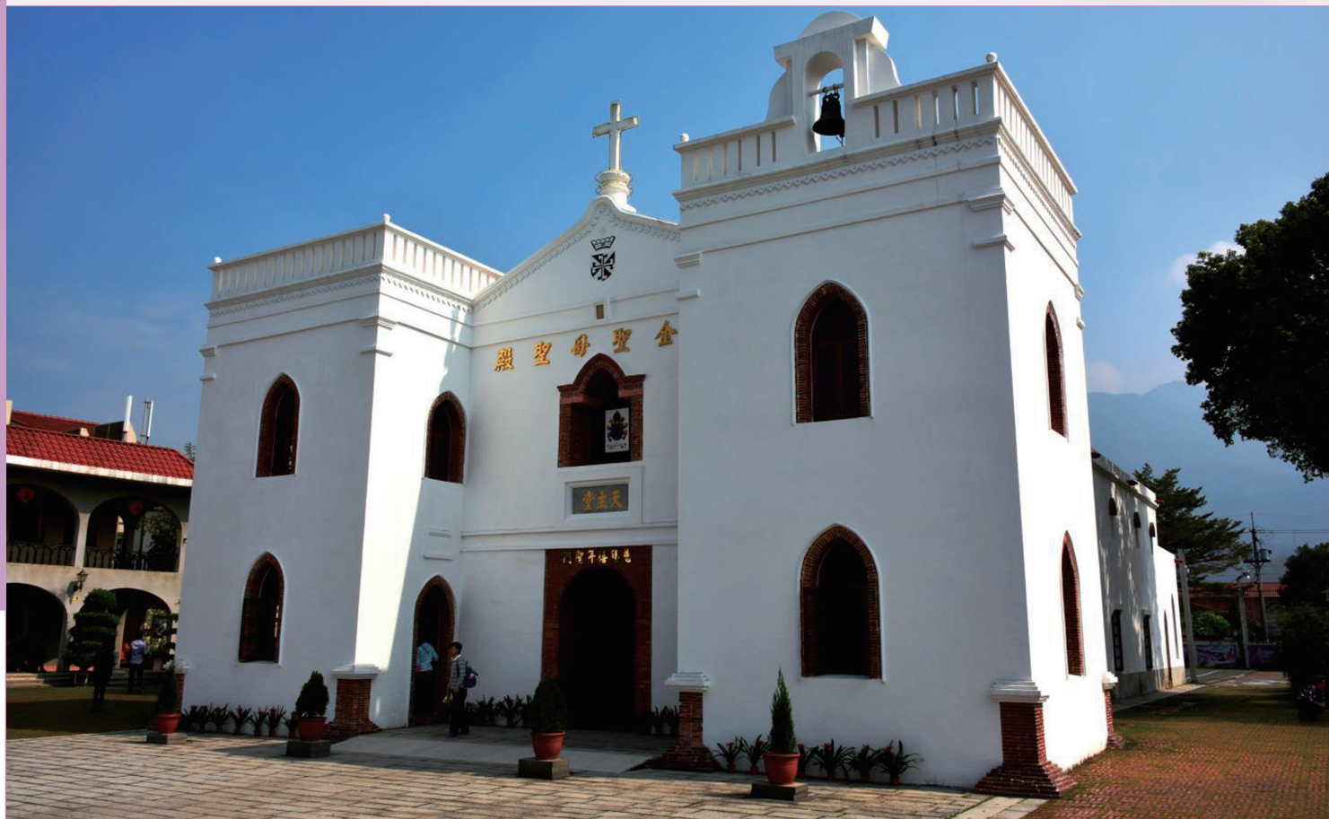
萬金天主堂，在草創教堂時遭異教徒燒毀後，於 1870 年混合黑糖、蜂蜜、糯米重建而成。據說清廷令沈葆楨鑄刻並鑲上「奉旨」、「天主堂」石碑，白色外牆益顯古樸。
