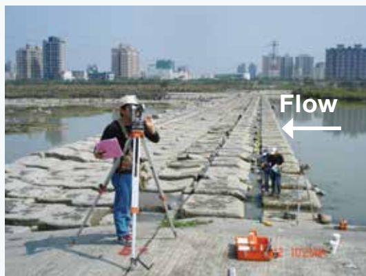
新竹頭前溪隆恩堰下游 800 公尺固床工
