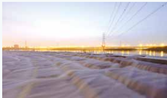
國道 3 號跨烏溪河段下游柔性固床工
