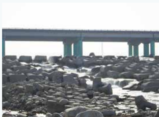
台中大甲溪國道 1 號下游側固床工
