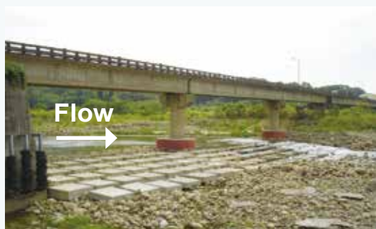
苗栗中港溪水頭屋橋下游側橋基保護工
