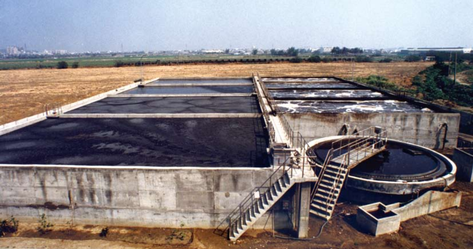
養豬廢水處理池
