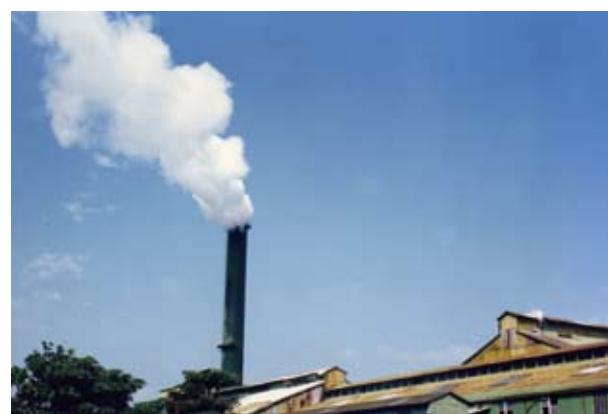
糖廠煙囪篩板除塵
