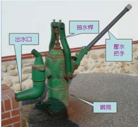
水井手壓唧筒式井口設備
