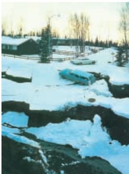
一九六四年阿拉斯加大地震的震災之一。地殼因錯動而產生數米高的位移，嚴重破壞道路及其它設施。
