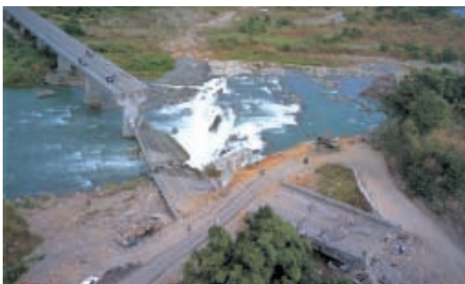
一九九九年集集大地震後，碑豐大橋斷裂，河床因斷層的垂直錯動而隆起，一夕之間造成了壯觀的瀑布，這種大自然的奇景堪稱世界僅有，也活生生地說明了台灣地區地震的活躍程度。
