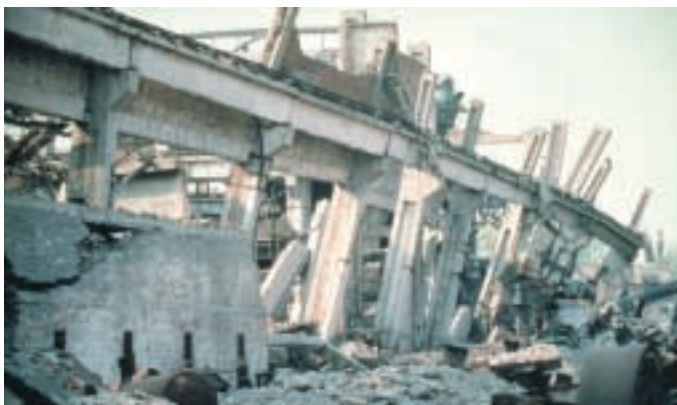
一九七六年唐山大地震之後的唐山市，幾乎夷為平地，到處一片斷垣殘壁，人員傷亡數字為近代歷史上自然災害之冠。
