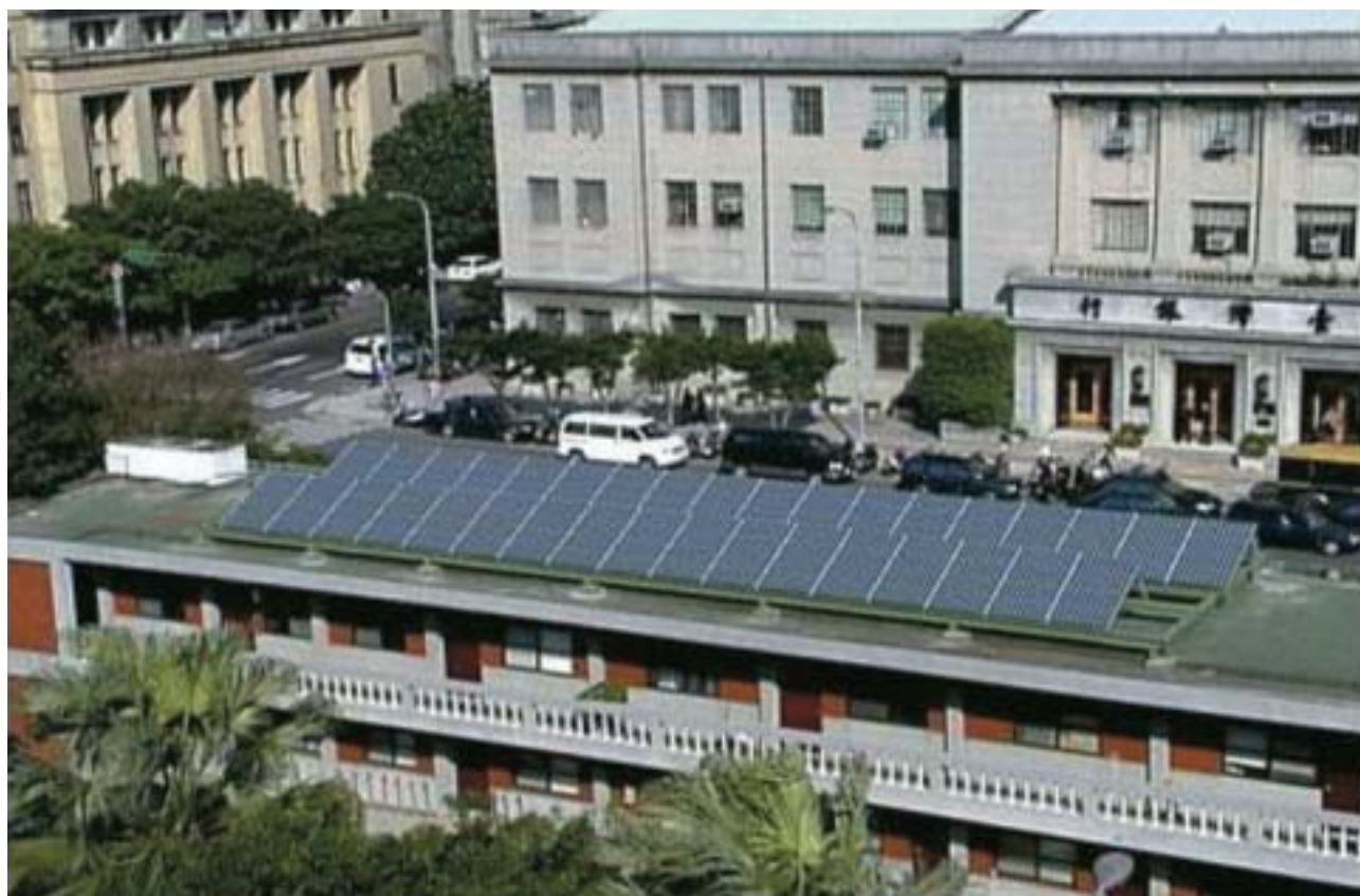
設置於總統府力行樓樓頂的太陽光電發電系統
