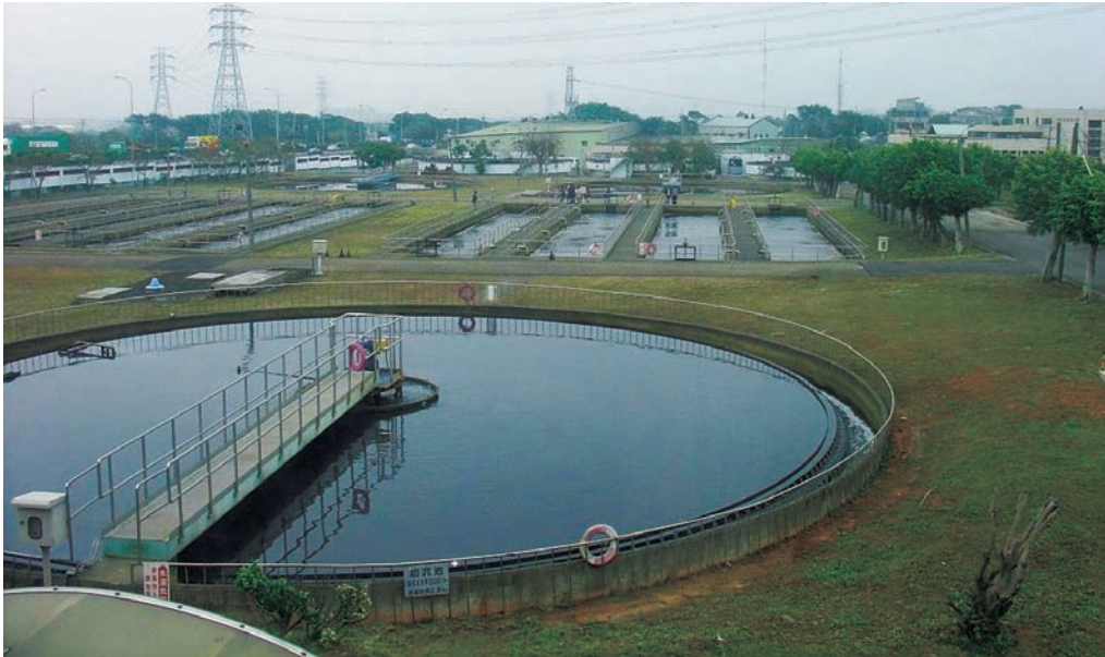
把薄膜放在上方的4個曝氣池中，可取代傳統大型圓形沉澱池，有效節省土地成本。
