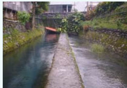
B2引水工程隧道出口（今）
