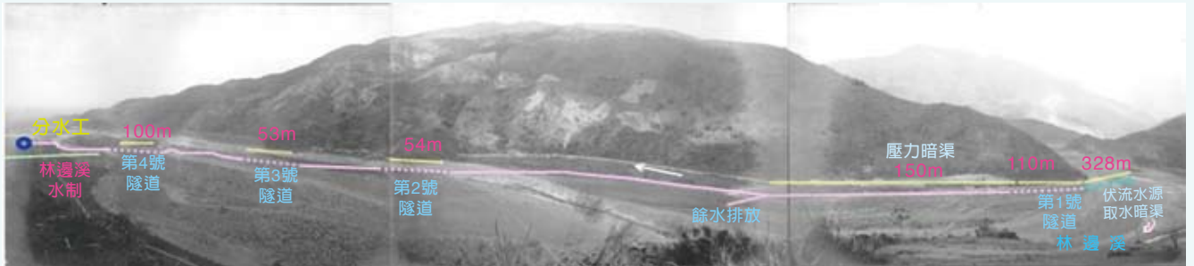
● 二峰圳引水工程
