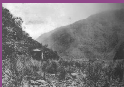
A1方形進水塔（人孔）（昔）
