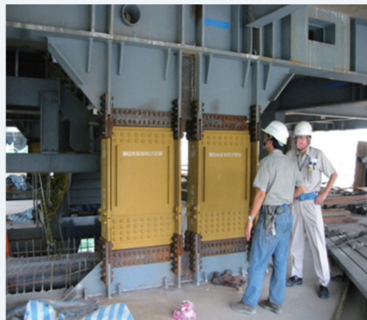
安裝在房屋結構上的黏彈性制震壁
