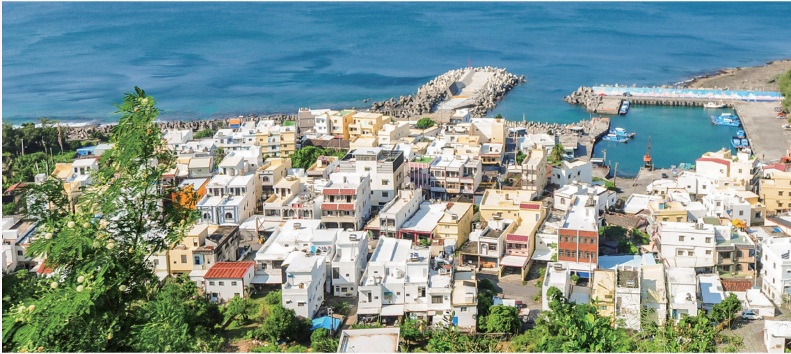
台灣最常見的屋頂型式是平屋頂，頂層的溫度通常較其他樓層高。（圖片來源：種子發）
