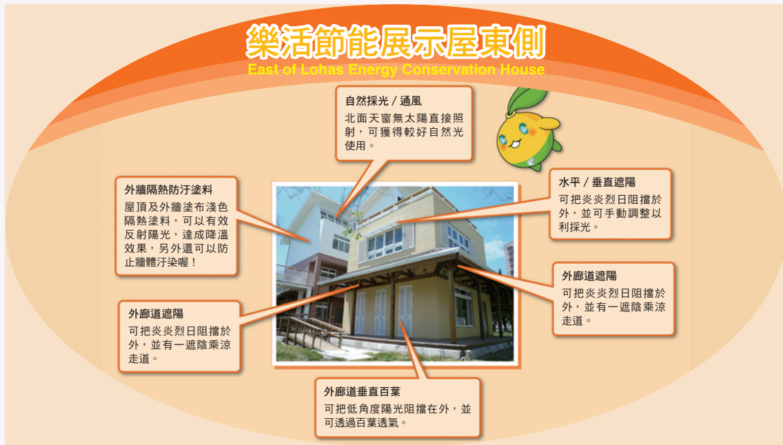
樂活節能屋東側的節能設施
