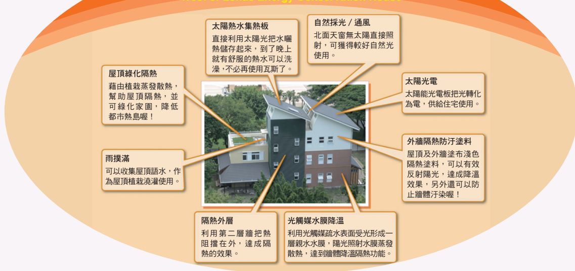
樂活節能屋西側的節能設施
