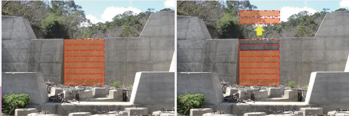
屏東縣恆春東門溪三台山封閉型防砂壩可依土砂量調整橫桿
