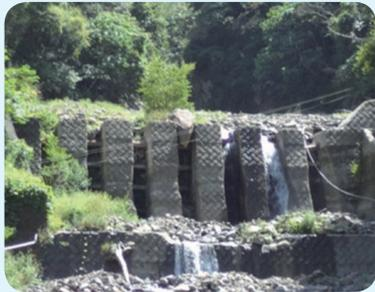
原防砂壩具 6 支墩柱搭配鋼管橫桿
