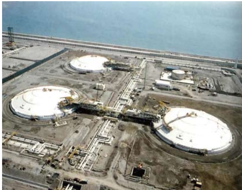
液化天然氣儲槽
