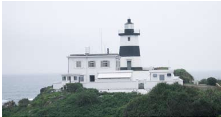
● 燈塔的基本架構大致相同，但每一座燈塔都各具特色。這是富貴角燈塔，原稱「富基角燈塔」，看出它和三貂角燈塔的明顯差異嗎？它是八角形混凝土塔身，外漆黑白條紋。
