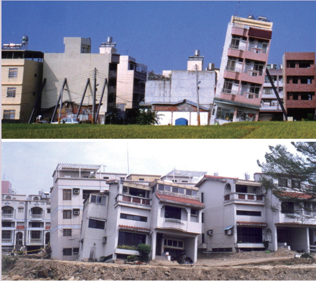
集集地震土壤液化造成台中霧峰樓房傾斜
