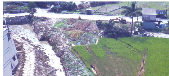
土壤液化引致台中霧峰地區的地盤側向流動破壞
