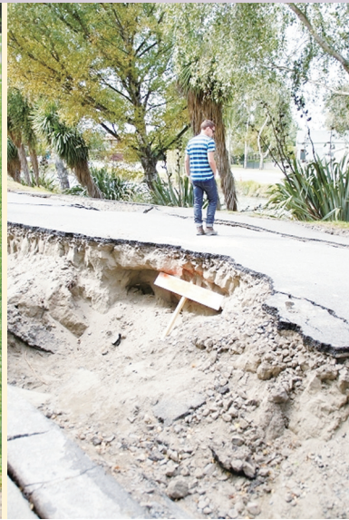
Avon 河附近大規模側潰引致路基與維生管線破壞
