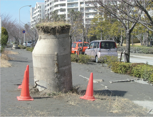
2011 年日本東北地區大地震土壤液化造成地下管線地人孔上浮
