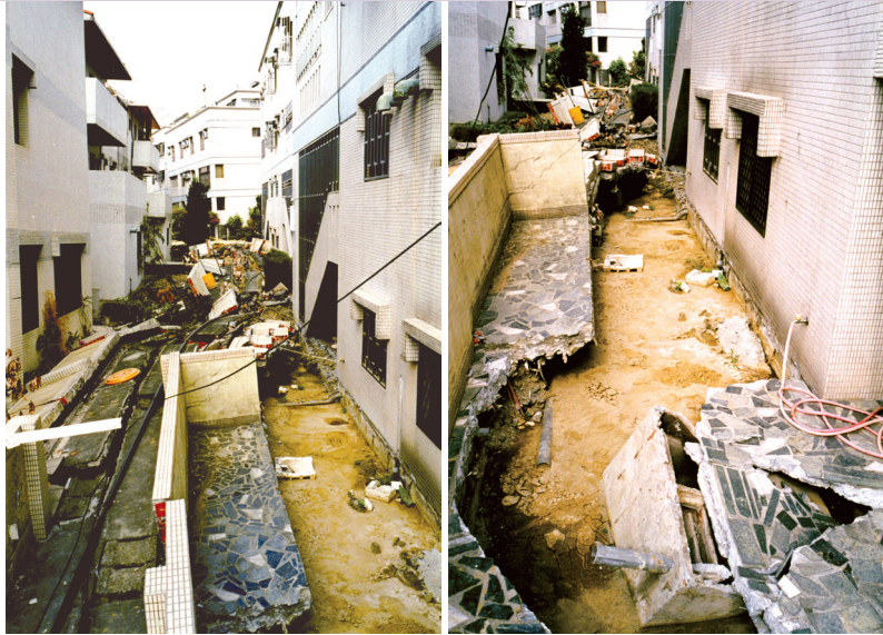
集集地震土壤液化造成台中霧峰房舍受損與地下污水池上浮
