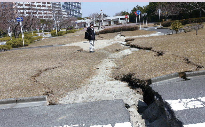
東日本大地震造成的濱海公園與堤岸的側潰破壞現象
