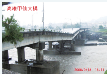
橋梁在颱風侵襲期間的沖刷倒塌
