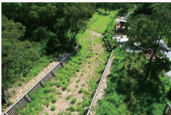
河道兩岸木格框護岸內填石塊鞏固兩岸以抵抗沖刷
