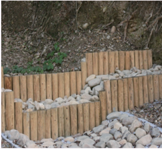
坑溝節制壩可減輕逕流沖刷
