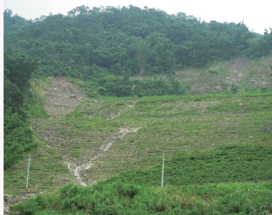
打樁編柵完工（上）及完工後1年植生綠覆穩定進入（下）。
