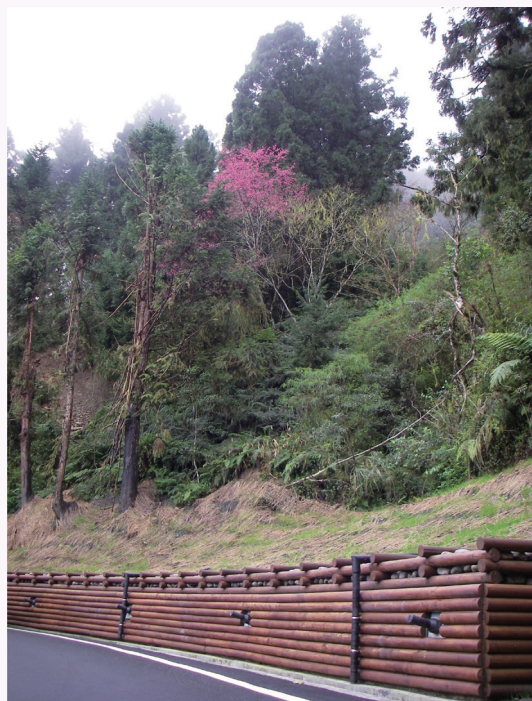
林道上邊坡混凝土地錨拉力牆以原木裝飾外觀
