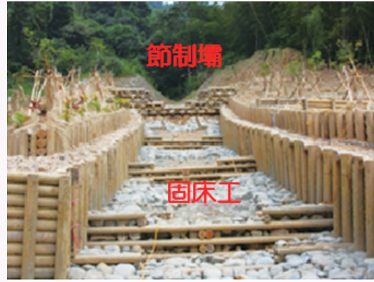
坑溝上的節制壩與固床工
