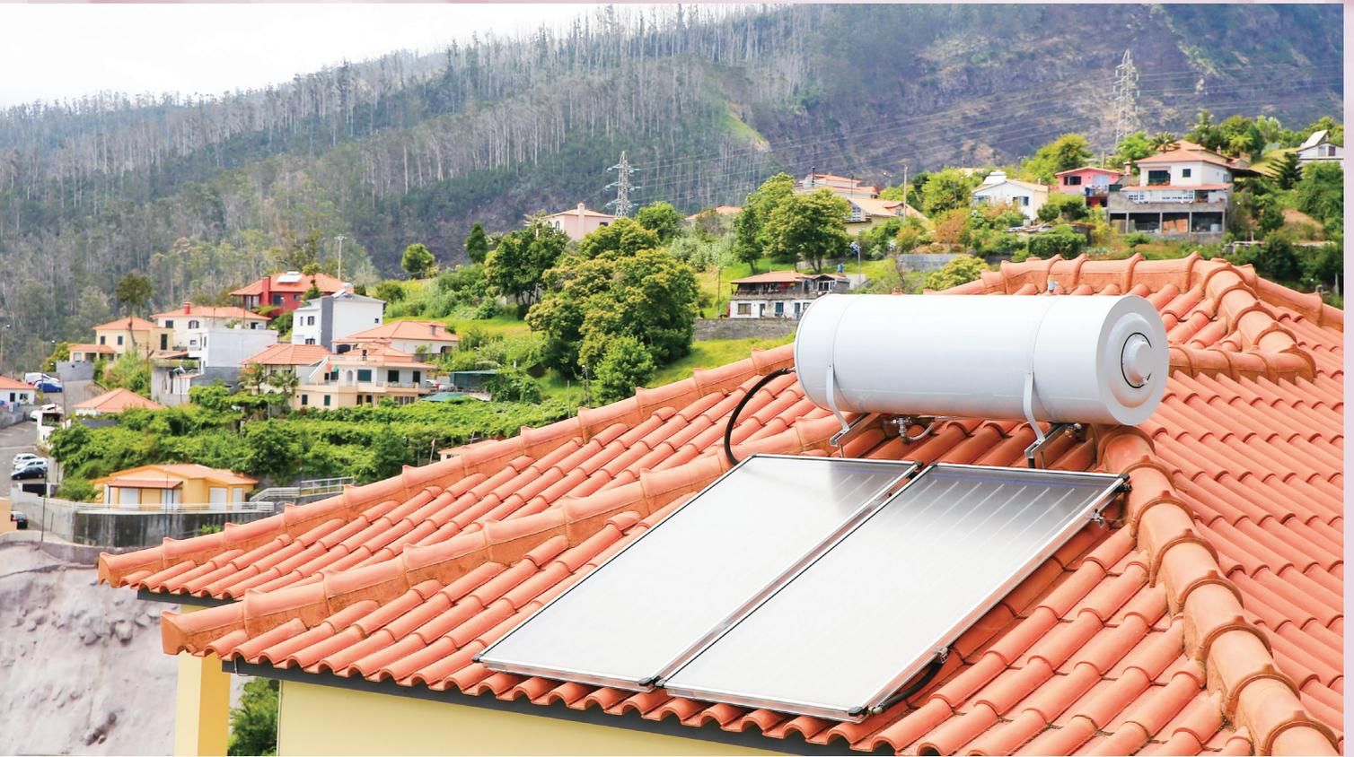
太陽能熱水器可由兩塊 2 米 × 1 米的模壓鋁板組成吸收太陽能器材。(圖片來源：種子發)
