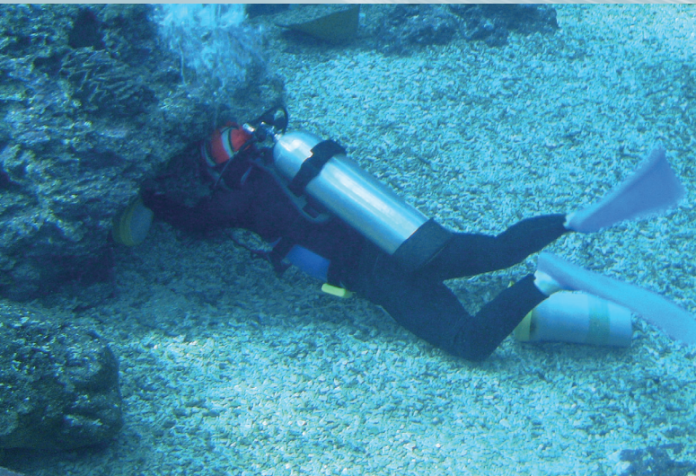
潛水人員正在維修維生系統處理過海水的進水管
