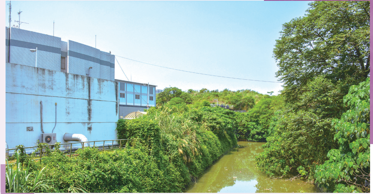
光復抽水站旁仍遺留一小段新店溪舊分流河道，但已退化為排水溝。
