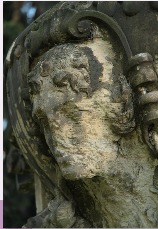
大理石由碳酸鈣組成，對酸雨很敏感，很多大理石建築因酸雨而嚴重受損。
