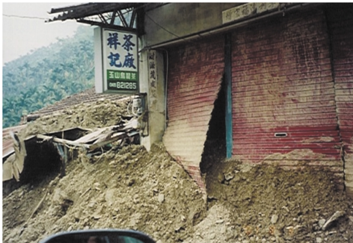
土石流穿堂入室 土石流無堅不摧，大量土方湧入廳堂。
