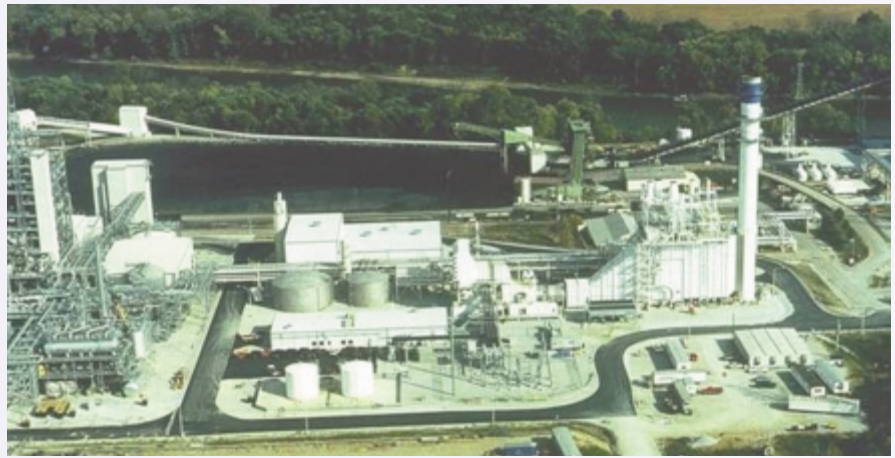
煤氣化複循環發電廠
