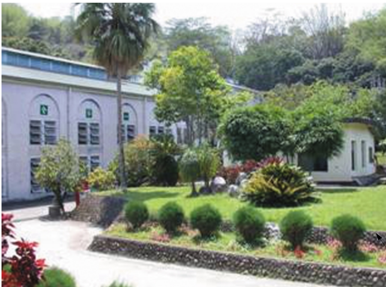
這個四周充滿綠意的巴洛克式建築，是南台灣最早的發電廠。由當時的總督府在荖濃溪上游設壩引水，並以水流落差發電。於一九〇九年完工後，發電量2,000千瓦，四台水輪機中目前仍有三台可以運轉發電。
