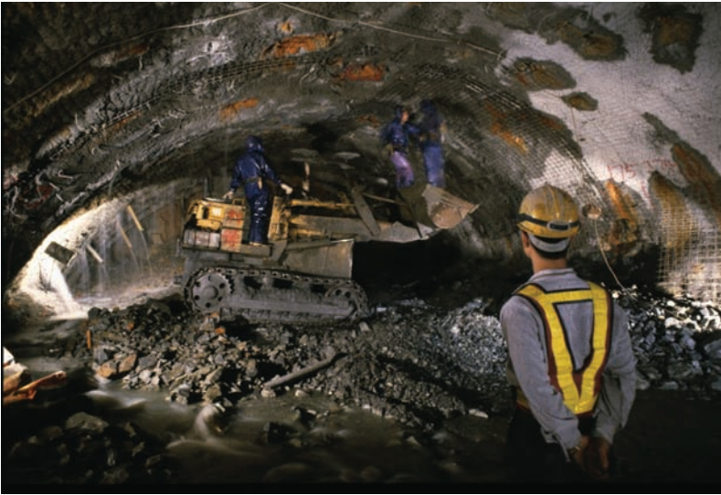
斷層破碎帶改採頂導坑工法施工
