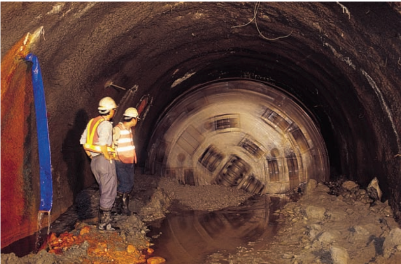
導坑 TBM 開挖（混合工法）
