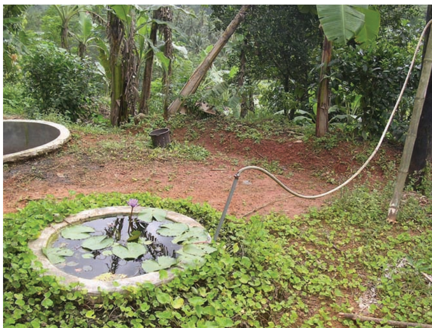
許多開發中國家在農村推行小型的沼氣槽，利用動物的糞便產生甲烷用於烹煮食物。
