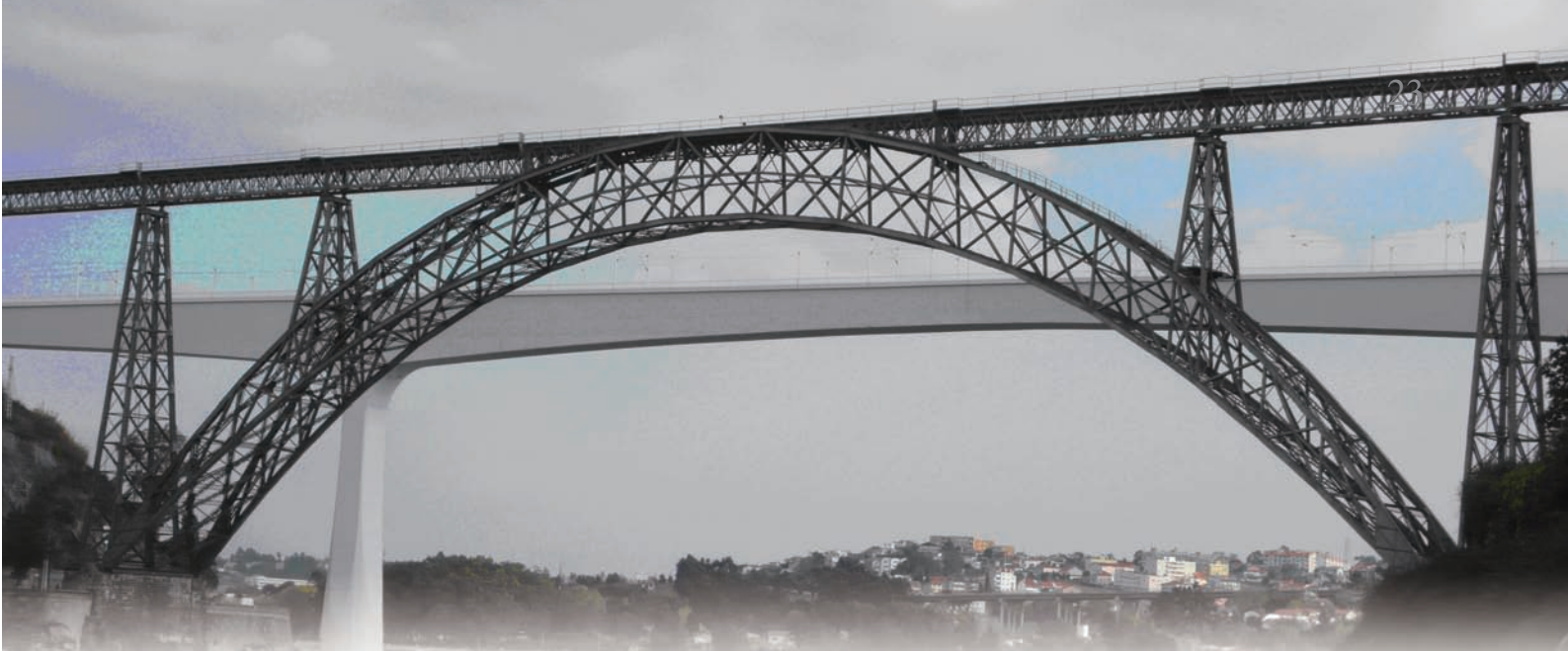
橋梁常成為都市的地標與國家工程科技實力的指標。上圖是葡萄牙波耳多市多羅河上於1877年所建造跨度是160公尺的Maria Pia 桁架鐵拱橋，這座橋是艾菲爾（G. Eiffel）先生的團隊在設計巴黎鐵塔前的成名作，背後則是現代化的大跨度鋼箱型梁橋。
