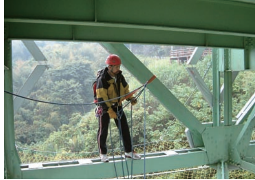
一些橋梁檢測車無法便利使用的橋梁，檢測人員必須使用特殊攀爬設備接觸到構件做目視或儀器檢測。
