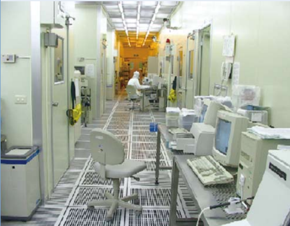
國家奈米元件實驗室的10級（class 10）潔淨室。進入這環境內的工作人員須穿著規定的潔淨衣、頭套與手套。
